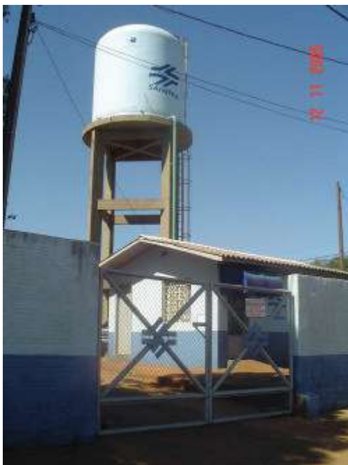
FIGURA 89 – FOTO DO LOCAL DO RESERVATÓRIO DE ÁGUA MUNICIPAL.
