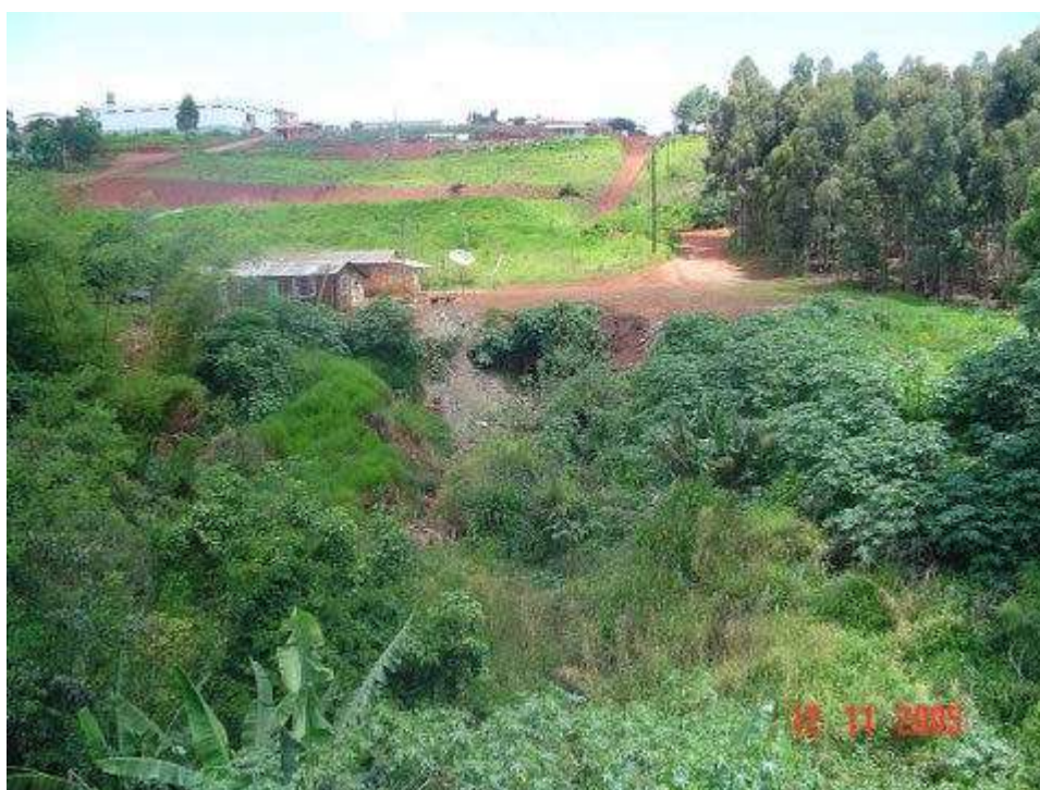
FIGURA 78 – LANÇAMENTO DE ENTULHO NA EROSÃO
