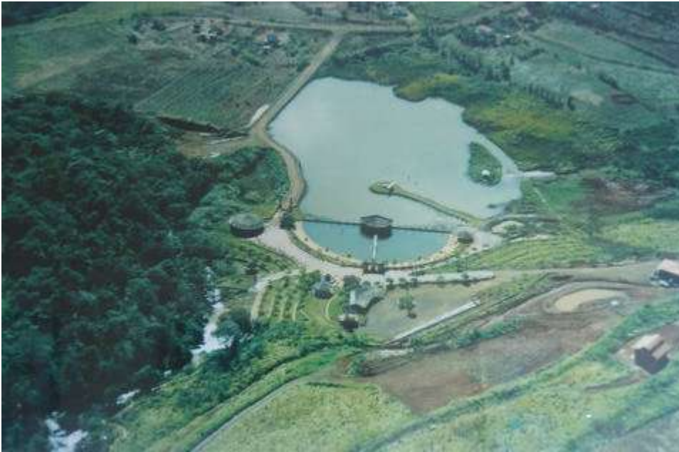
FIGURA 69 – VISTA GERAL DO PARQUE DAS ANTAS
